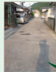
●住宅地の市道整備
