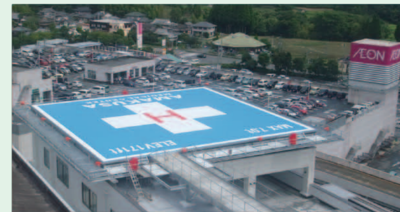
建設が進む「ヘリポート」
