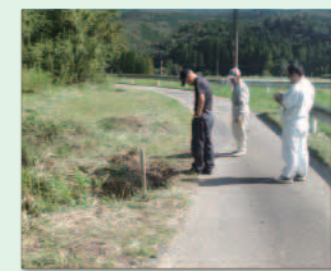
危険箇所の確認
