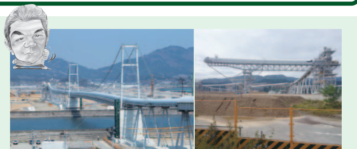
陸前高田市の巨大ベルトコンベア(延べ3km・総工費1,200億円)1時間に5,500t(ダンプトラック550台分)の山土を運ぶ
