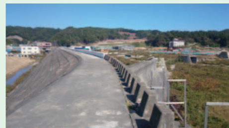
修理中のスーパー堤防と後方の山林(開発中)
