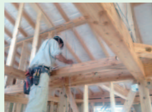
地元業者による リフォーム工事の様子
