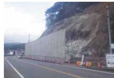
国道(志柿町)落石防止工事
